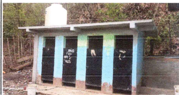
Foto 2: SUSTITUCION DE TECHO, TAZAS SANITARIOS.
